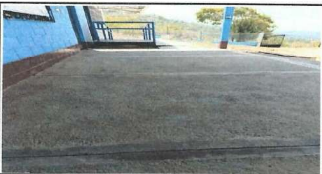
Foto 5: Instalación de piso cerámico en el corredor y salones de clase
