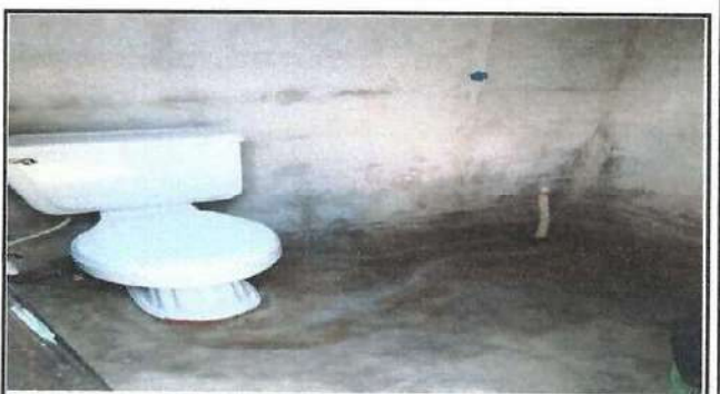
Foto 4: mejoras en el sistema de drenaje en los servicios sanitarios
