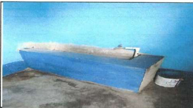
Foto 3: mejoras en el sistema de drenaje en los servicios sanitarios
