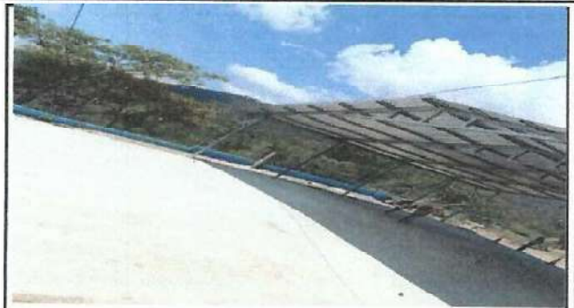
Foto 2: Instalación de estructura metálica con cubierta de lámina
